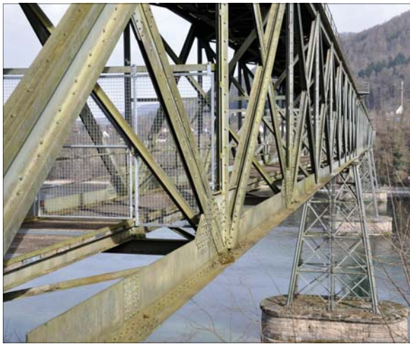
47 Die Eisenbahnbrücke Hemishofen. Blick in das Fachwerk mit dem Fussgängersteg, der heute gesperrt ist. Der Zug fuhr auf der „Decke“.
